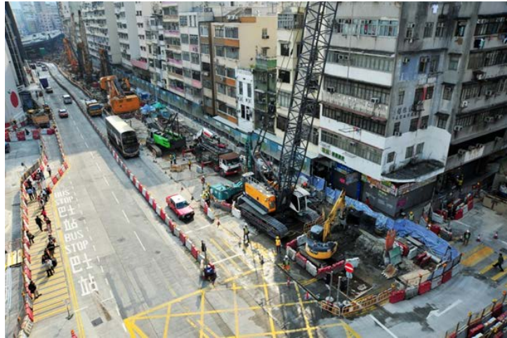
馬頭圍站工地
