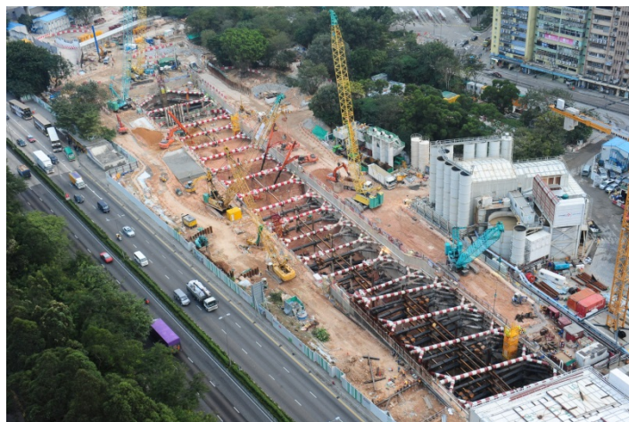
鑽石山站擴建工程
