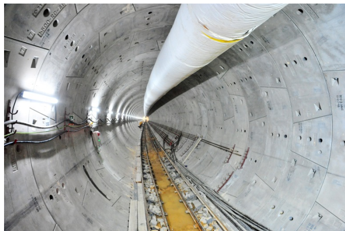
啟德往鑽石山方向的上行綫隧道
