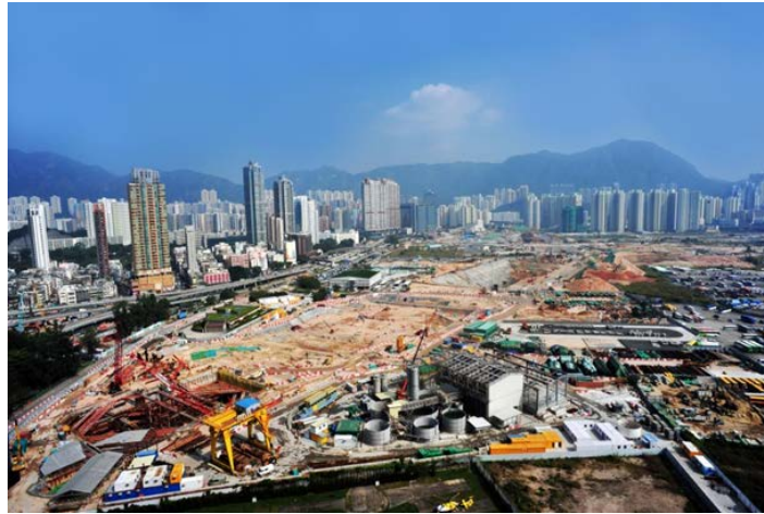
土瓜灣站工地
