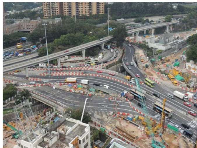
紅磡站以北的鋼管樁工程
