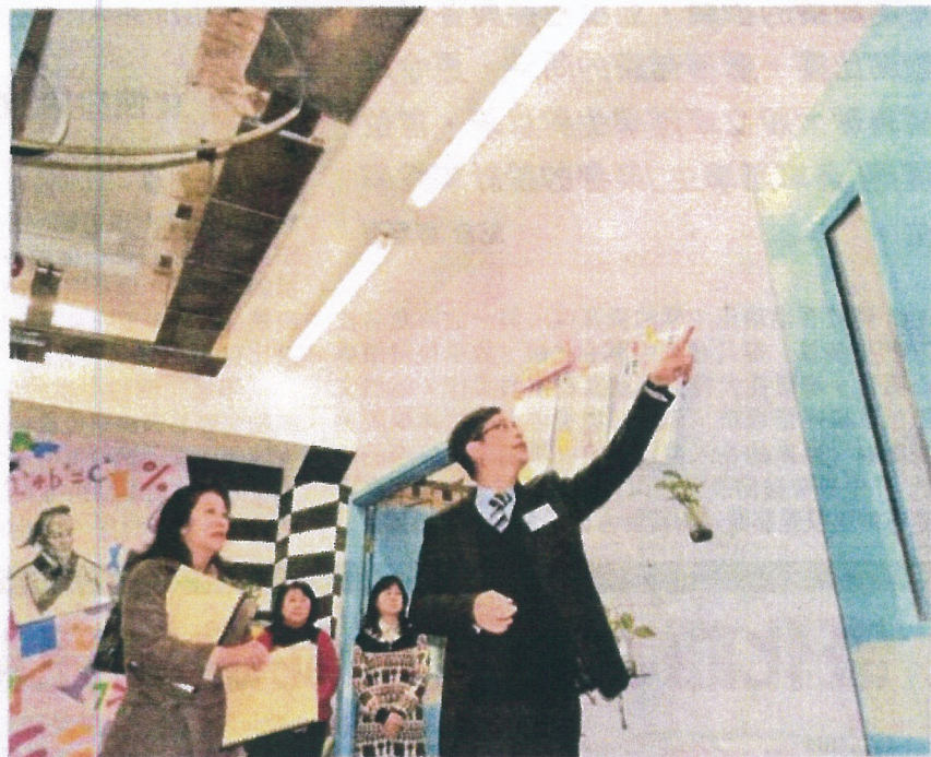
■信愛學校是典型火柴盒校舍，多處出現滲水及石屎剝落，葉建源(右一)指維修工程無補於事，應盡快重建，旁為校長趙劍眉。梁子健攝
