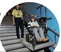
此外,金鐘、天后、鑽石山、油麻地及馬場5個車站,均設有自助輪椅升降台,輪椅使用者可使用通用匙自行操作升降台,或透過梯口的通話器聯絡車站職員前來協助。
