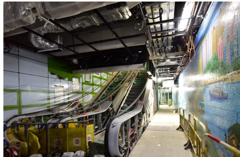
海怡半島站：裝修及機電工程現正進行
