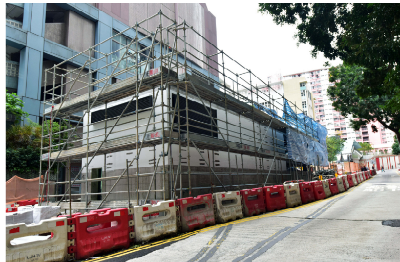
海怡半島站：車站出入口結構工程大致完成
