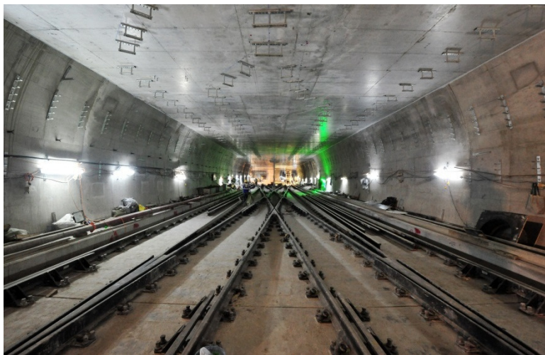
金鐘站至海怡半島站的軌道鋪設工程已完成
