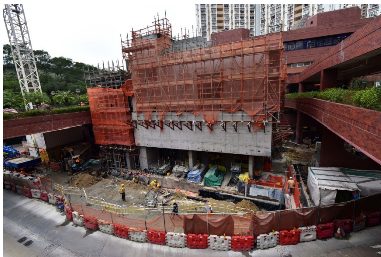
利東站：B出入口的豎井結構工程大致完成
