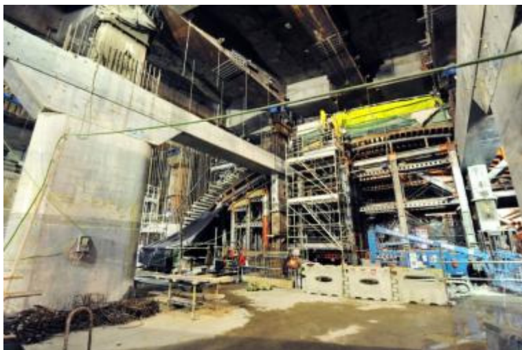
港島綫隧道支撐架挖掘工程已完成
