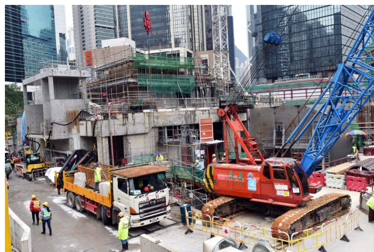
金鐘站平台花園層建造工程現正進行
