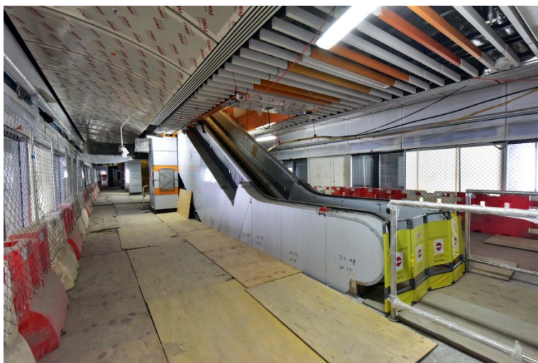
利東站：裝修及機電工程現正進行
