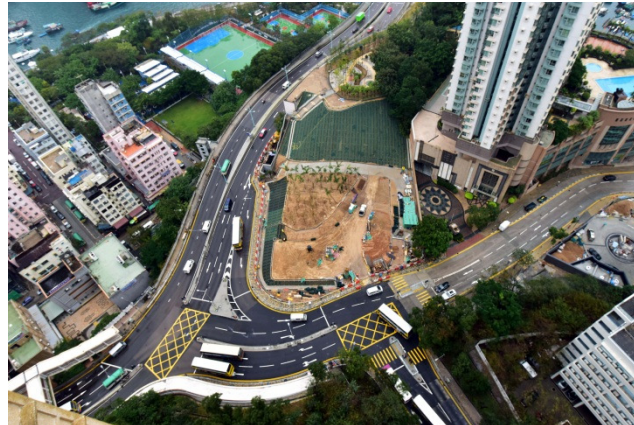
鴨脷洲徑與鴨脷洲橋道交界處 道路改善工程
