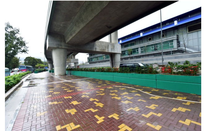
黃竹坑明渠改建工程
