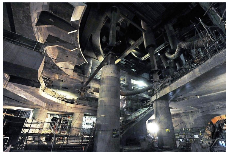
明挖回填挖掘工程大致完成
