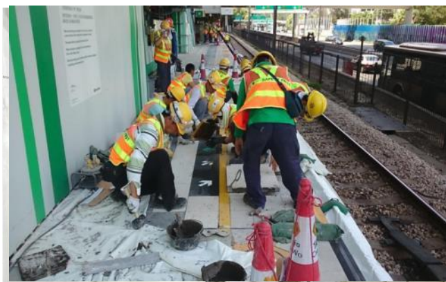
為配合加裝月台閘門，東鐵綫沿綫正進行月台加固及興建信號房
