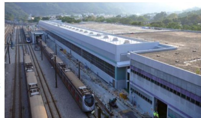
現有八鄉車廠改善及擴建工程已大致完成，大部分設施已投入服務
