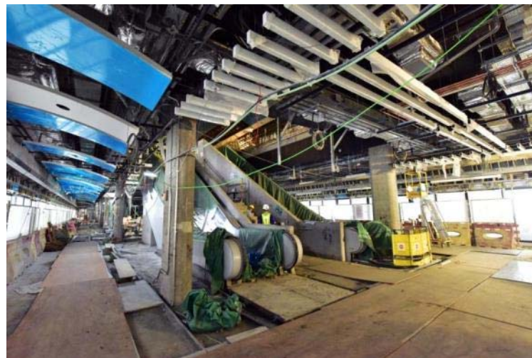
南港島綫（東段）月台層機電工程現正進行
