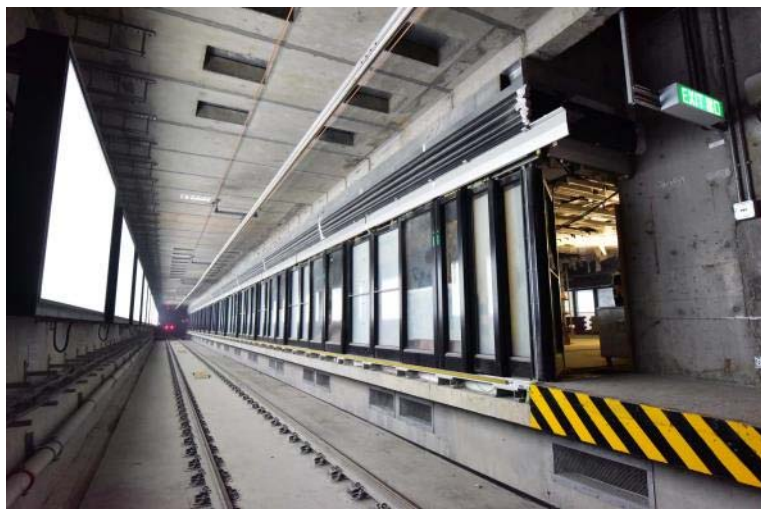
所有軌道鋪設工程已完成
