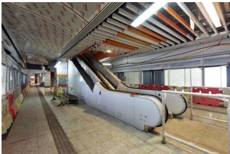
利東站：裝修及機電工程接近完成
