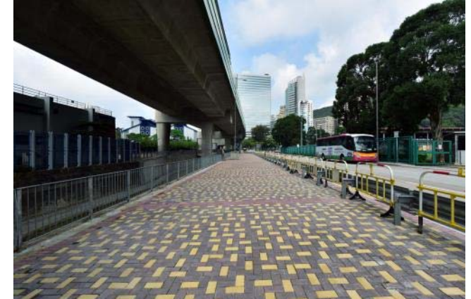
黃竹坑明渠改建工程已完成
