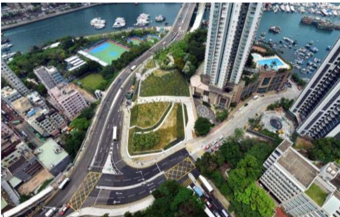
鴨脷洲徑與鴨脷洲橋道交界處 道路改善工程已完成
