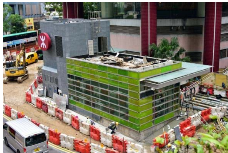
海怡半島站：車站及其出入口結構工程 已完成
