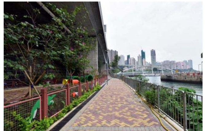
連接香港仔海峽海濱長廊 的行人通道建造工程大致完成
