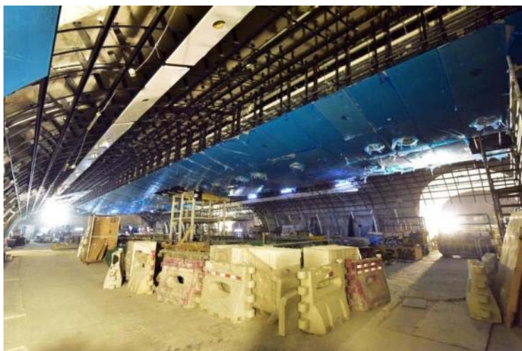
車站洞穴裝修及機電安裝工程現正進行
