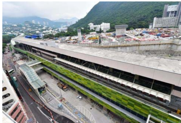
黃竹坑公共運輸設施已開放
