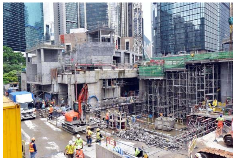
金鐘站平台花園結構工程現正進行
