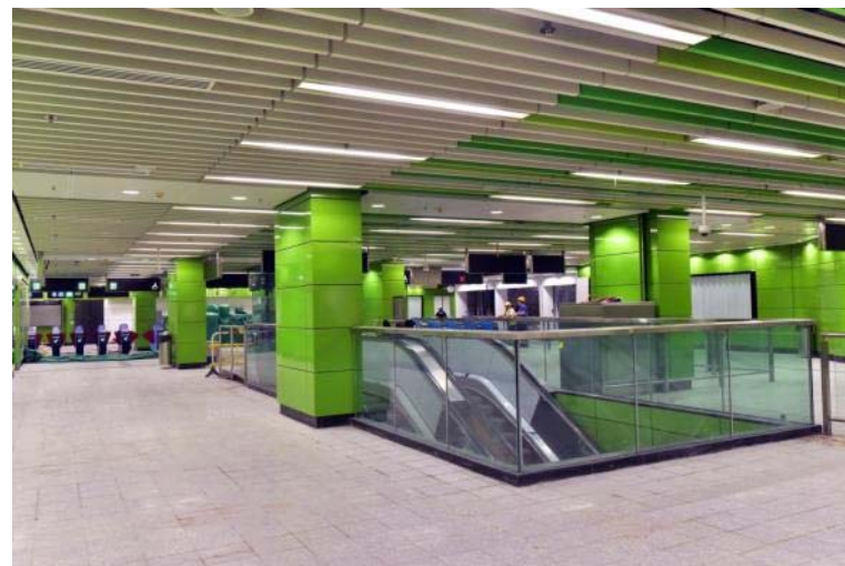
海怡半島站：裝修及機電工程接近完成
