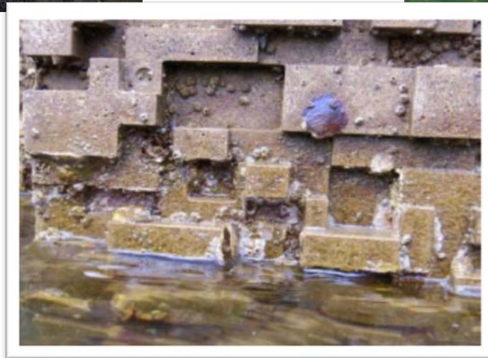
Eco-tiles 生態方塊
