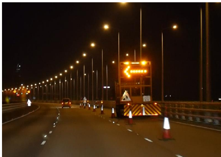
圖二：在封閉路段的前端加設備有車載式緩撞裝置的護航車輛及縱向安全淨距
