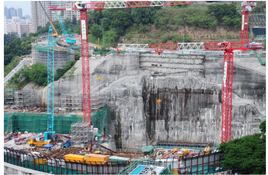
基座支撐工程
