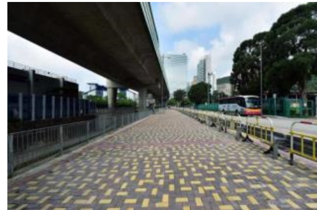
黃竹坑明渠改建工程已完成
