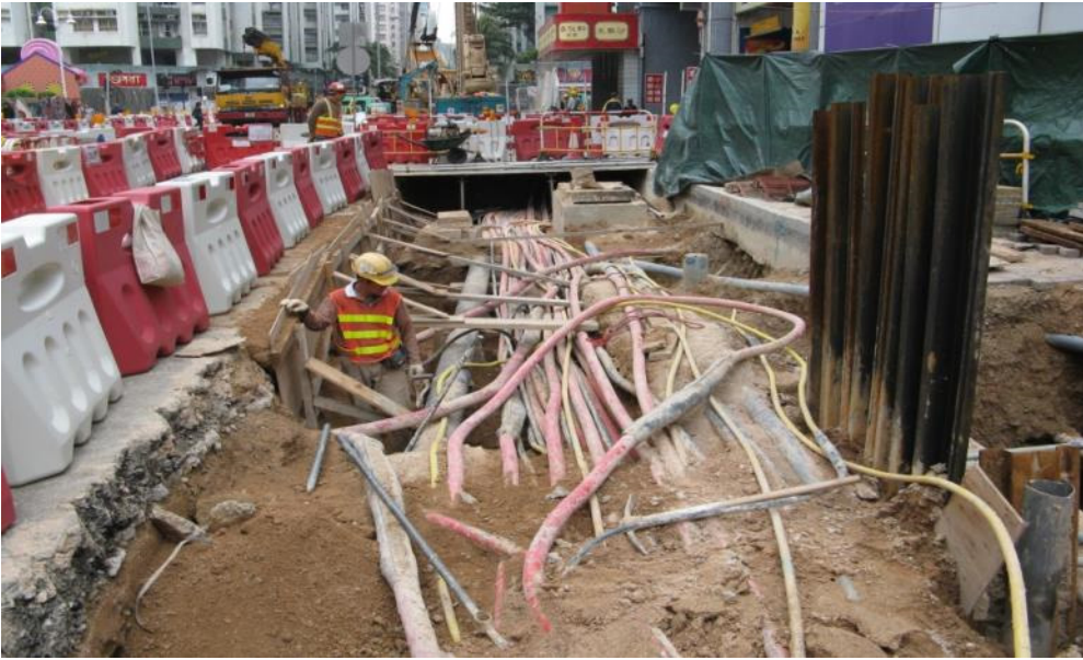
地下管綫重鋪工程
