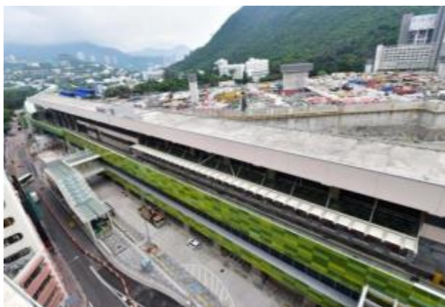
黃竹坑公共運輸設施已開放
