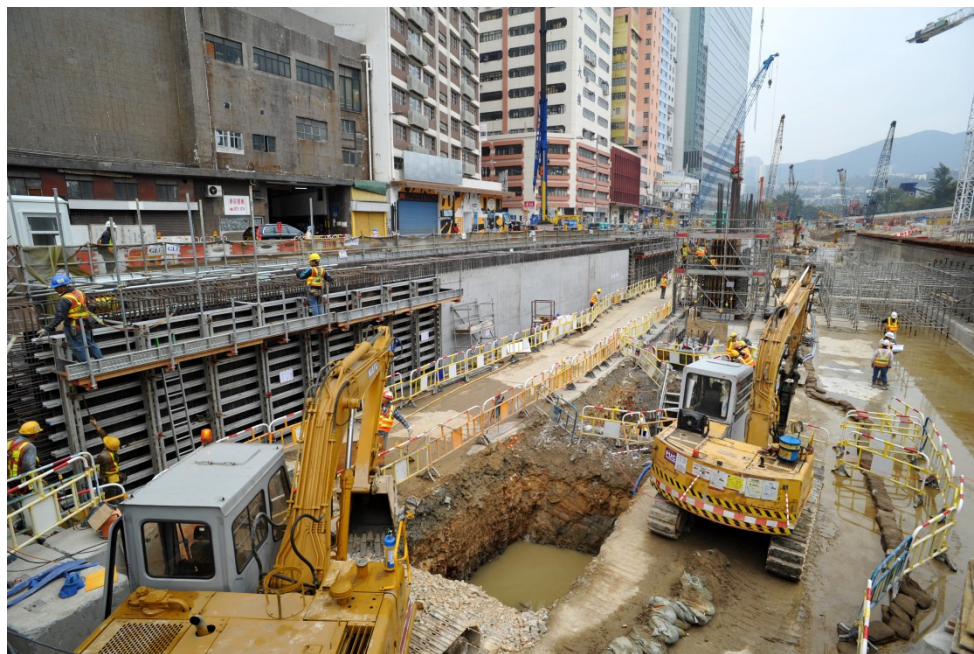
明渠內的挖掘及鑽孔樁工程只可在旱季進行
