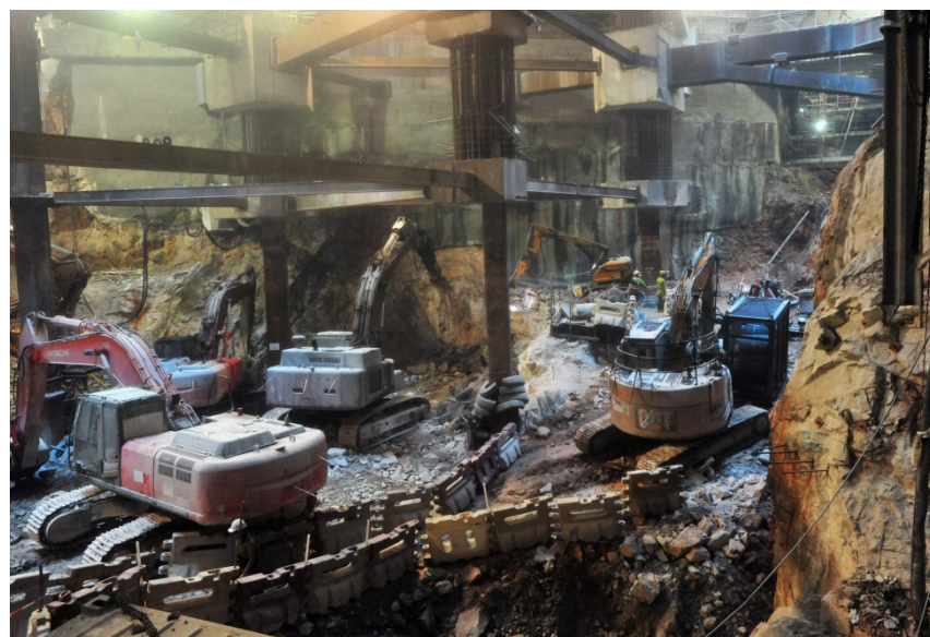
增加及採用更大型挖掘機械
