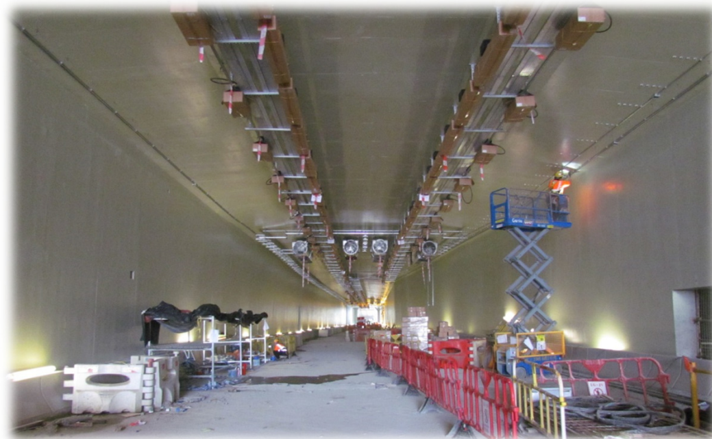
柯士甸道西/連翔道地下行車道 結構工程進行中
