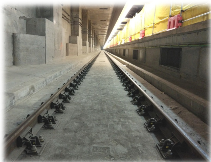
總站月台層之軌道鋪設工程已完成
