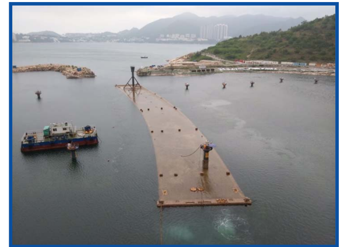
首件預製組件浮起
