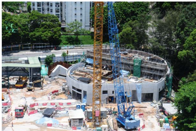
馬仔坑通風樓結構工程
