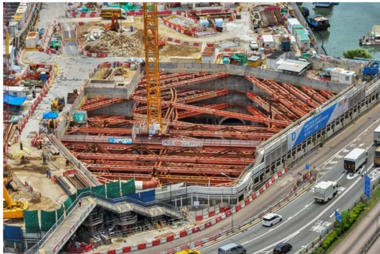
於前警官會所工地的通風設施挖掘工程
