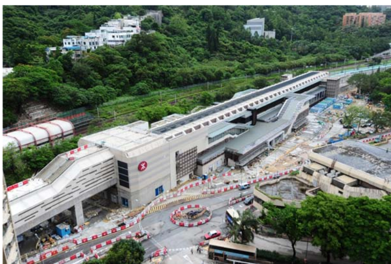
顯徑站及部分高架橋
