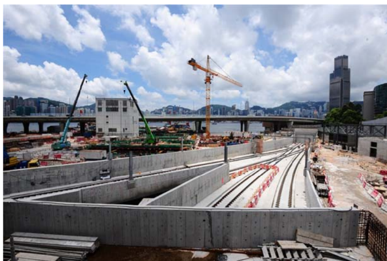
在紅磡列車停放處進行的路軌鋪設工程
