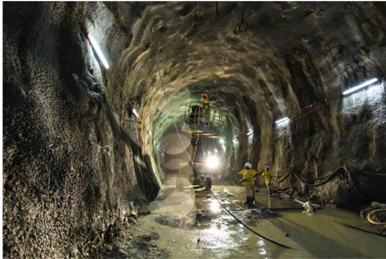
沙中綫越位隧道的鑽爆工程於二零一七年六月完成
