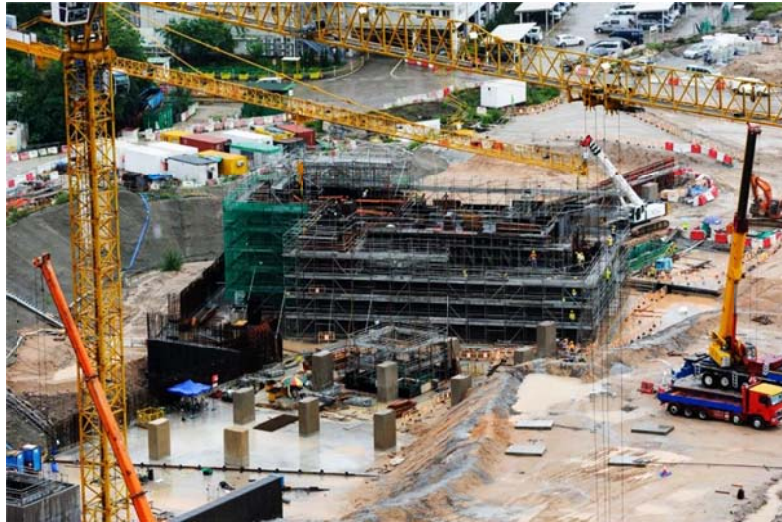
土瓜灣站結構工程
