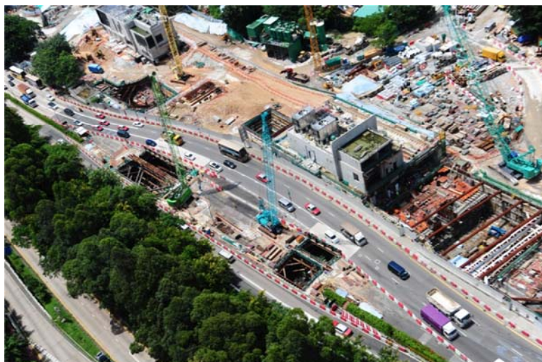
鑽石山站擴建工程
