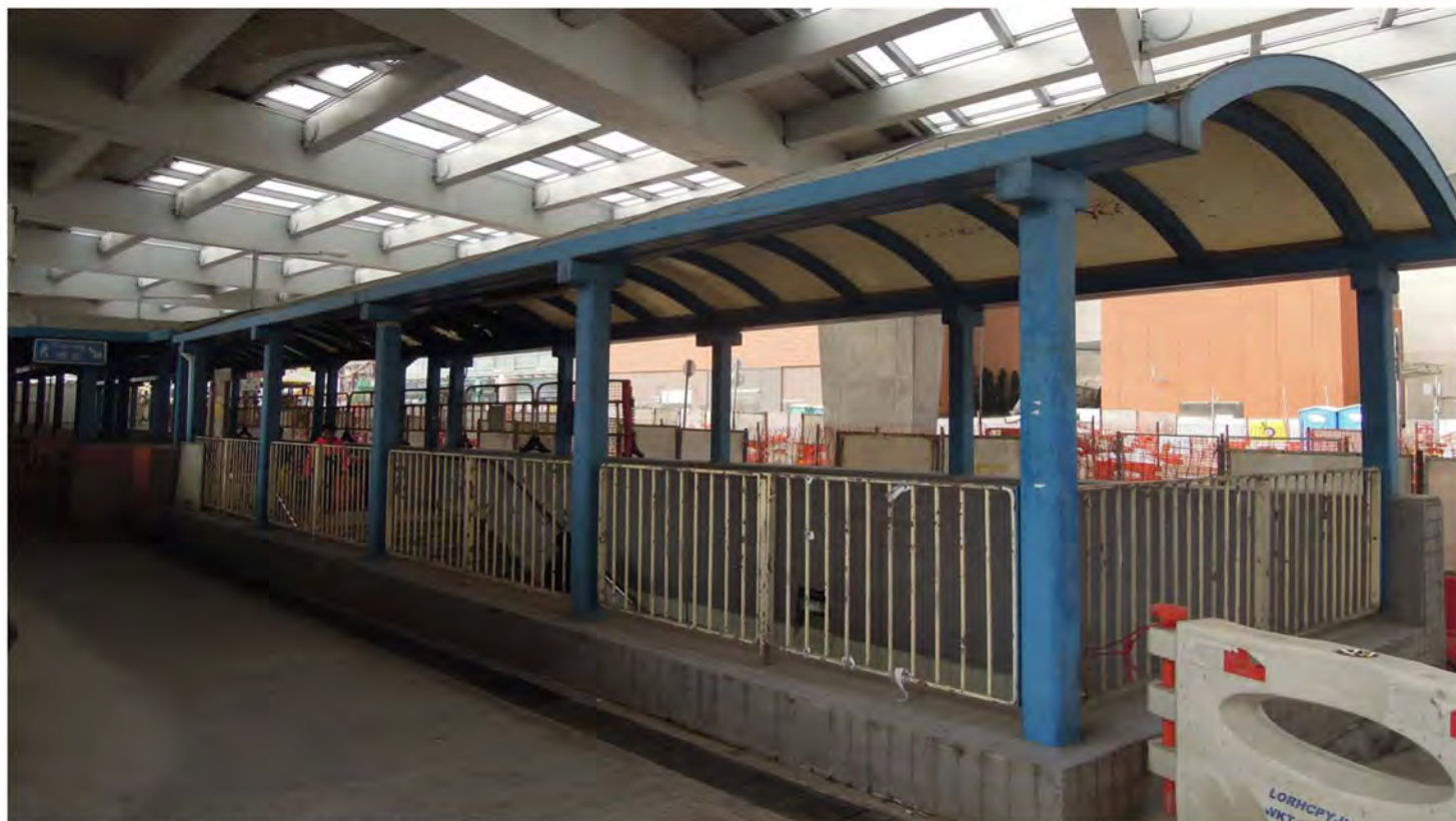
柯士甸道行人隧道戲曲中心入口 - 現時狀況
