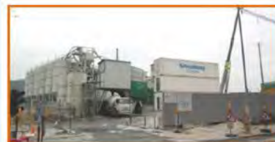
水泥廠 Cement Works
