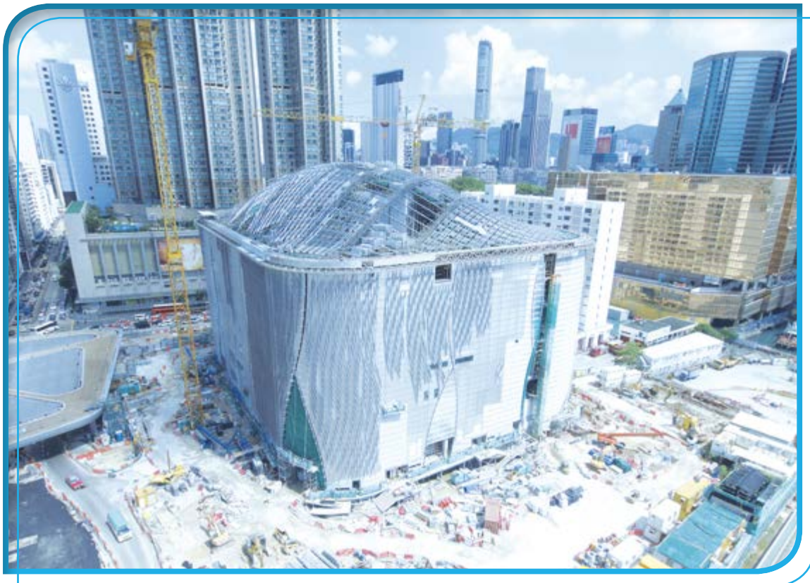
Xiqu Centre nearing completion 戲曲中心接近完工
