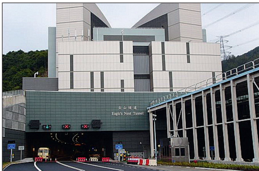
照片二 尖山隧道
