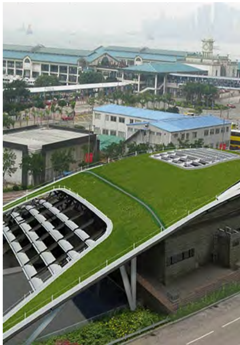
中環灣仔繞道和東區走廊連接路隧道西面通風大樓
