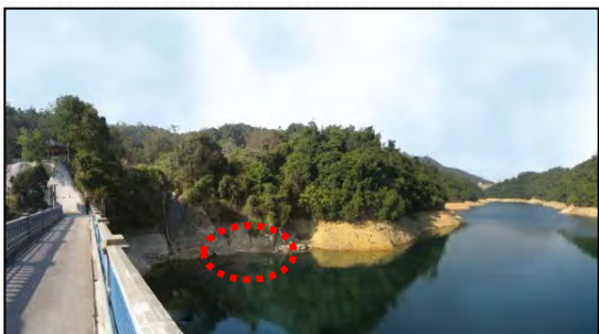
位於九龍副水塘的進水口位置
