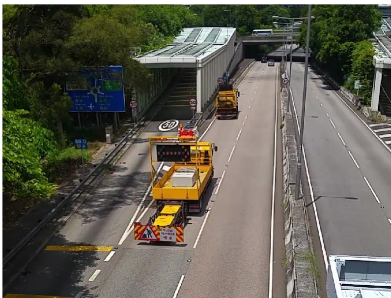
圖三：進行流動作業時使用備有車載式緩撞裝置的護航車作護航
