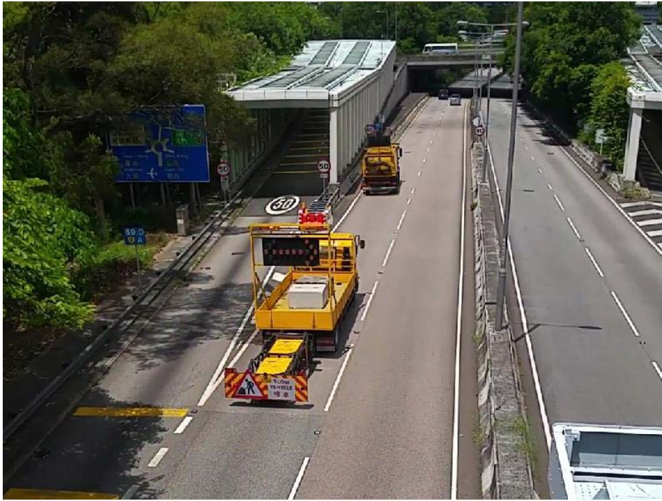
圖三：進行流動作業時使用備有 車載式緩撞裝置的護航車輛作護航
