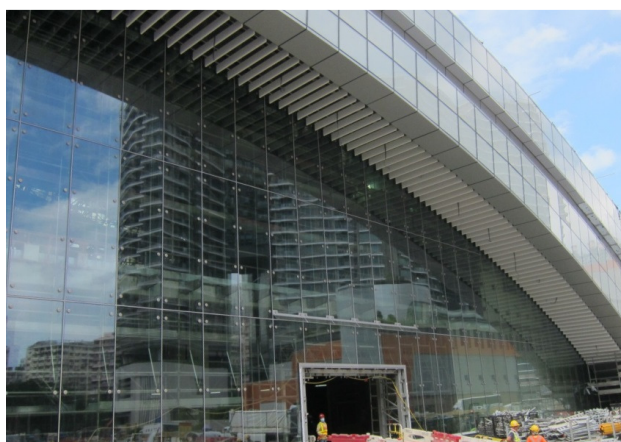
西九龍站入口東面拱門的建造工程
