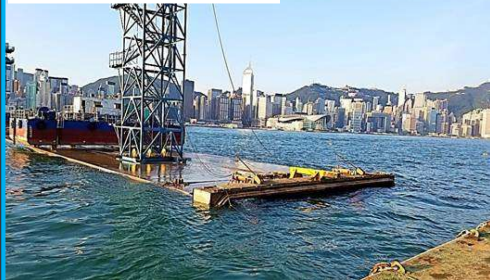
安裝過海隧道預製組件
