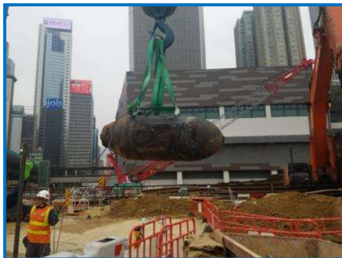
動用工地吊機吊運炸彈
