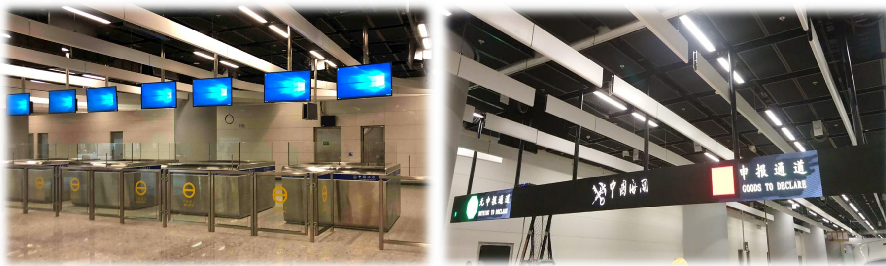
口岸區內設備安裝
