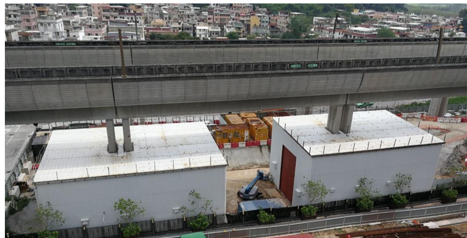
高架橋臺支撐加固工程
