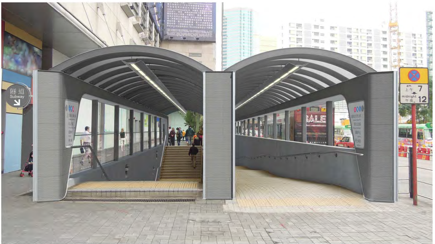
柯士甸道行人隧道近港景峰入口 - 美化工程完成後
