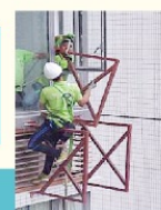
改良的吊棚承托架
