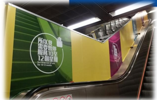
大型扶手電梯翻新工程
