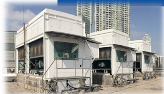
車站冷卻空調系統更換工程
