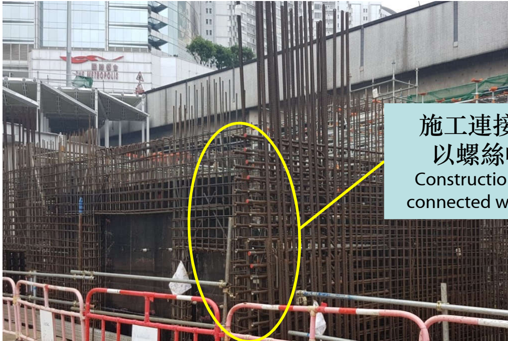
連接隧道牆身 Tunnel wall
