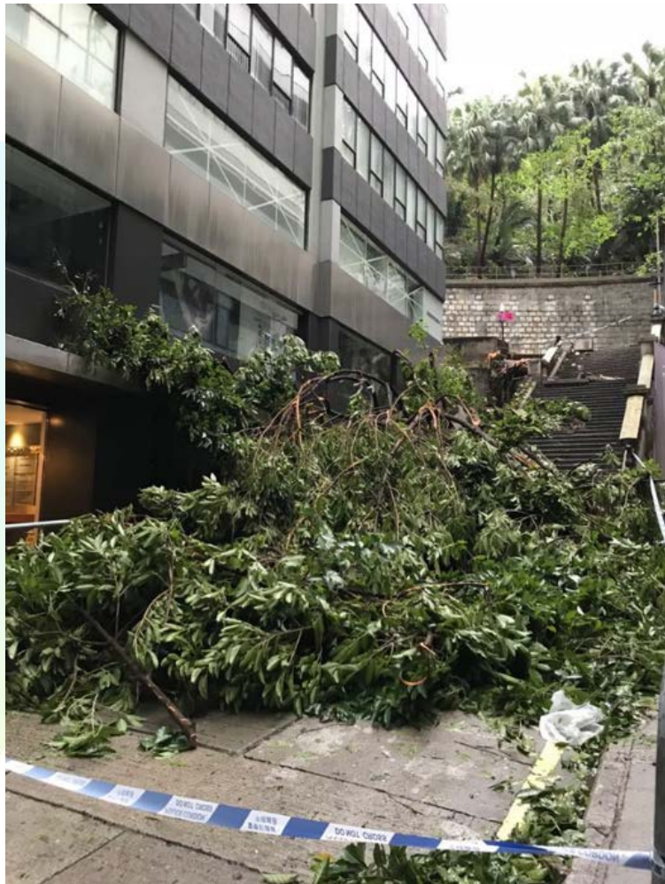
受倒塌石牆樹破壞的石階和煤氣路燈
