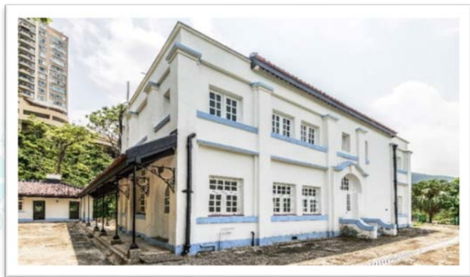
大潭篤原水抽水站員工宿舍群
