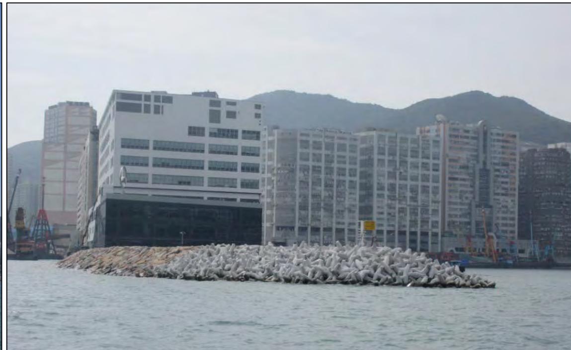
柴灣防波堤末端 預製混凝土組件放置完成情況
