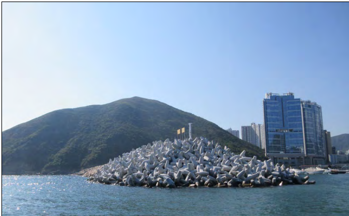
香港仔防波堤末端 預製混凝土組件放置完成情況
