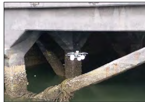
無人機檢查碼頭承台結構
