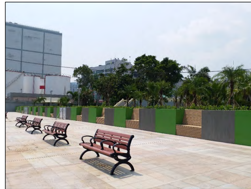
杏花邨遊樂場 建造花槽
