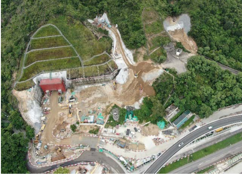
主連接隧道入口工地開拓工程 Site formation of main access tunnel portal
