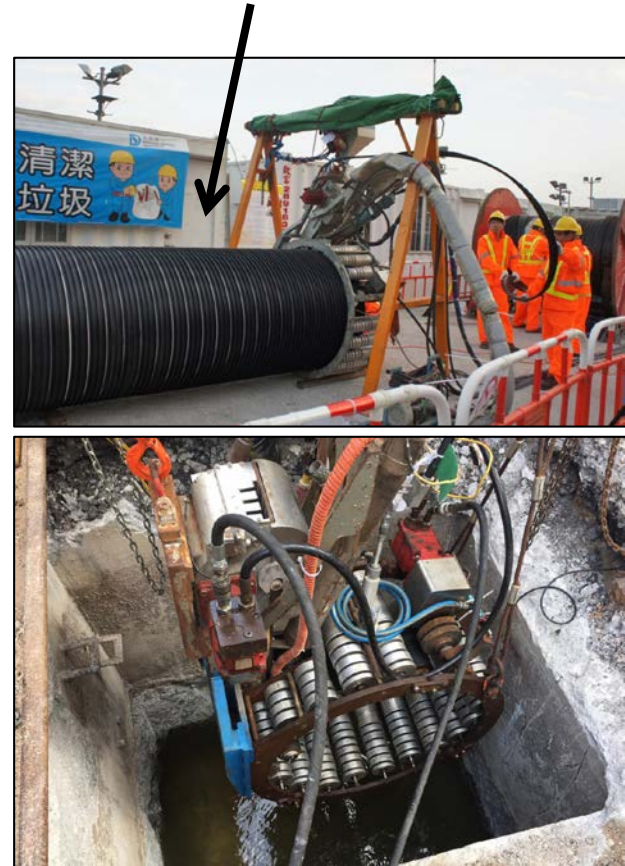
(3) 螺旋纏繞修復示意圖
