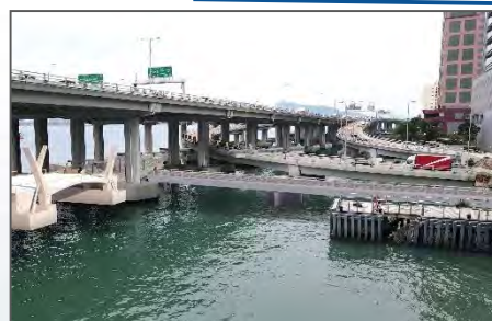
連接橋 2 Link Bridge No.2
