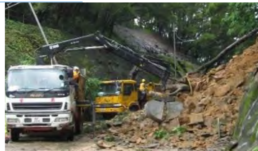
緊急維修工程
