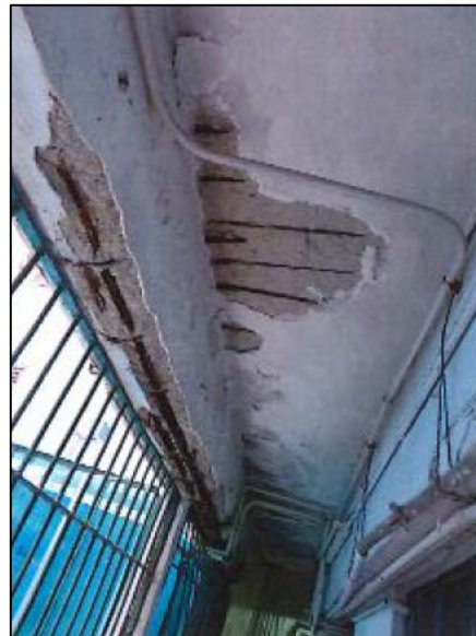
(d) Spalling of concrete in corridor
