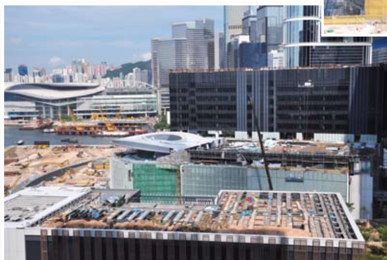
施工中的立法會綜合大樓建築工程。
