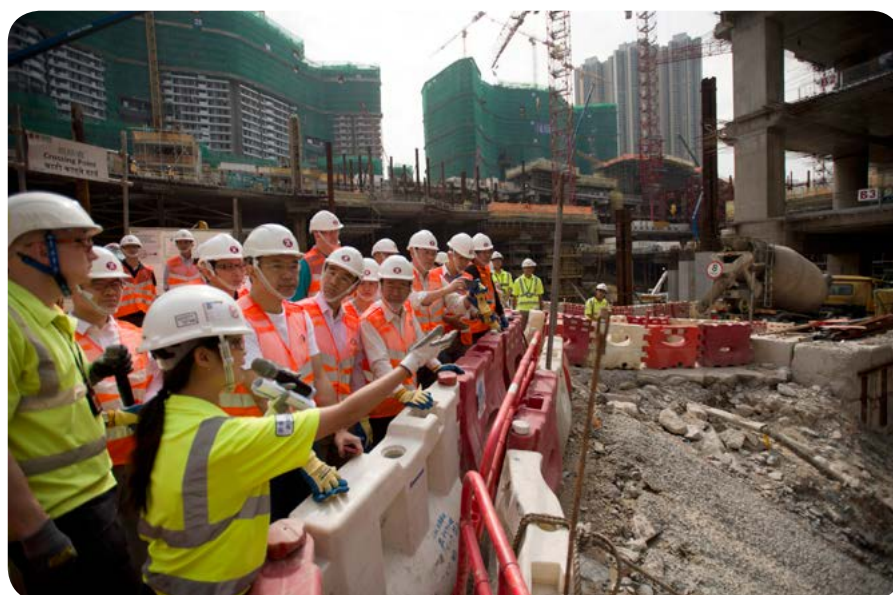
鐵路事宜小組委員會委員視察廣深港高速鐵路香港段西九龍總站的建築工地。
