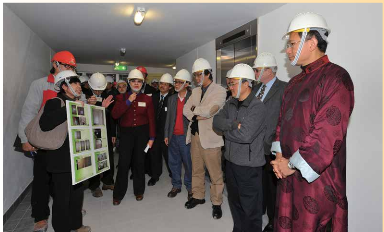
房屋事务委员会委员在视察启德公营房屋建筑工地时，听取有关“绿茵家居”主题的简介，而多个房屋项目的设计及建造工程都已采纳了这个主题。
