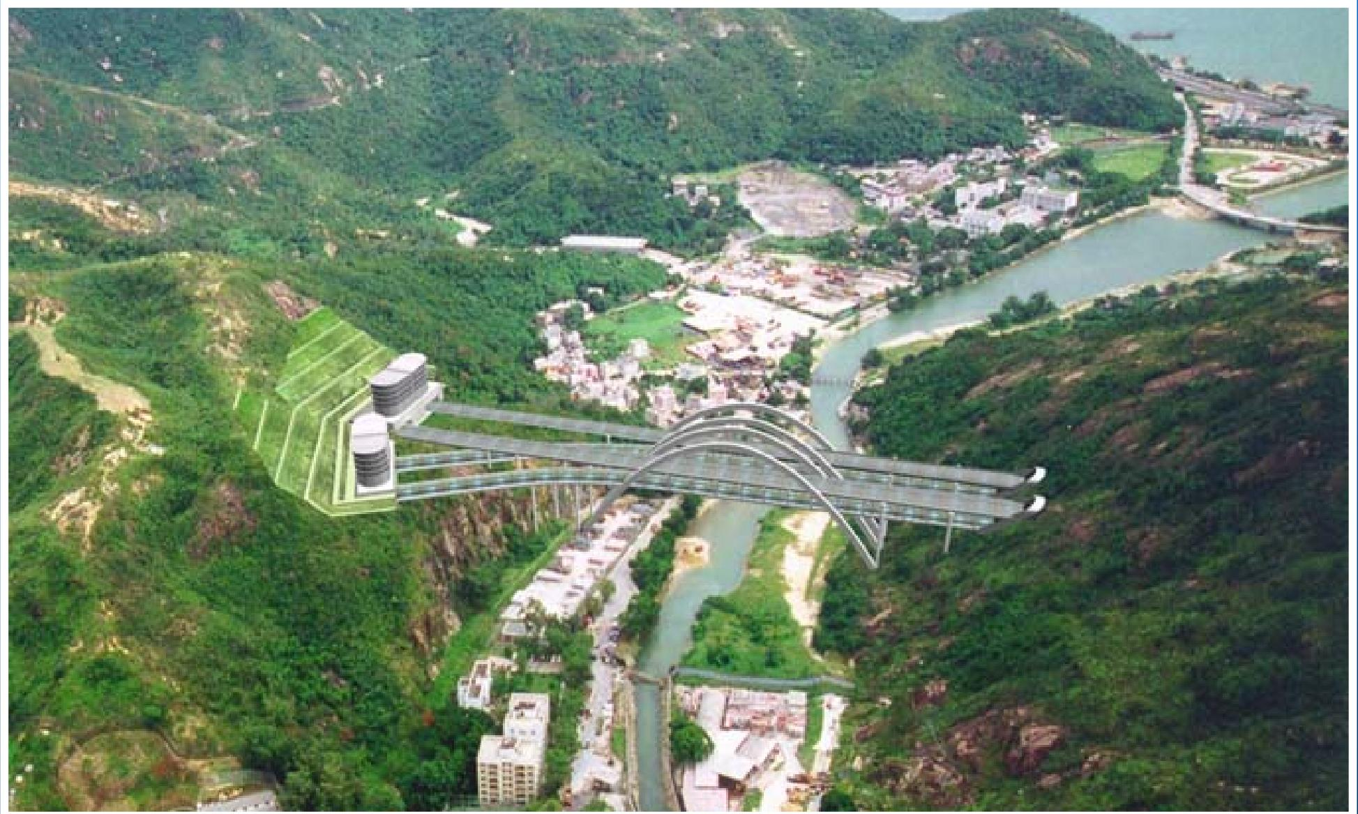
大欖涌拱橋以及隧道替代削坡
