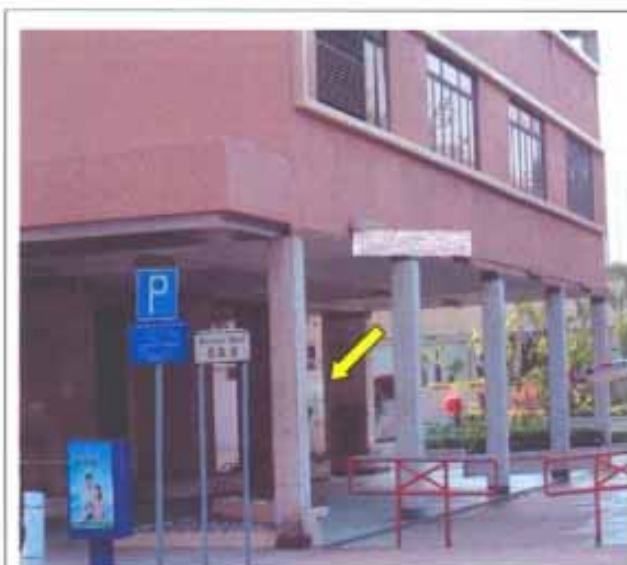
大廈出入口，有天花板但沒有圍封
