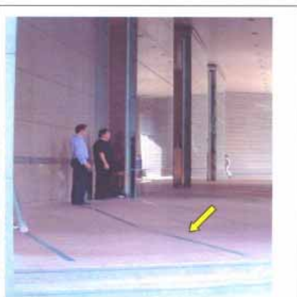
商廈地面出入口，有天花板但無圍封
