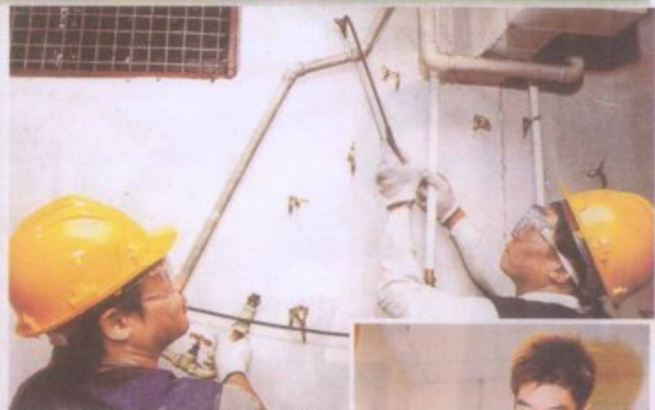
房署實施食水管重鋪計劃，為884幢公屋大廈更換不會生鏽的鋼喉。
