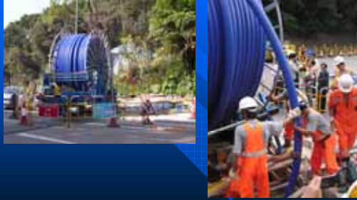
緊貼內置喉管法(相片一)
