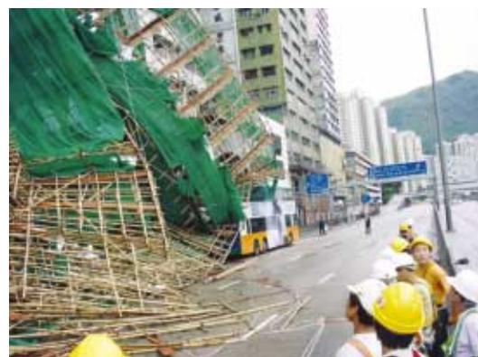
2.26 正常情況下，當颱風迫近時，本港的風速會逐漸增強，香港天文台會有充分時間預早警示，讓承建商拆下竹棚上的尼龍網，減低竹棚承受的風力。承建商亦會特別縛緊竹棚，令棚架更為牢固，避免被強風吹倒。不過，這次風速在下午十二時三十九分突然加強，以致承建商沒有時間採取任何防風措施以防止棚架倒塌。
