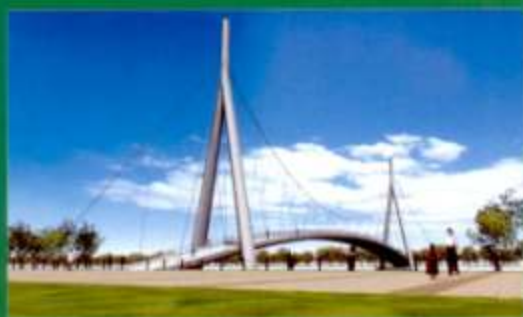
橫跨東面水道的特色行人橋
