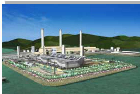
港燈首台天然氣發電機組將於2006年下半年投產 Commissioning of LNG-fired unit in 2nd half of 2006
