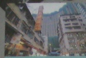
荃灣屏風樓 荃灣是屏風樓的重災區，舊樓重建及西鐵上蓋物業加起來超過三十幢高樓，將荃灣海邊圍困。 photo by: 柏輝
