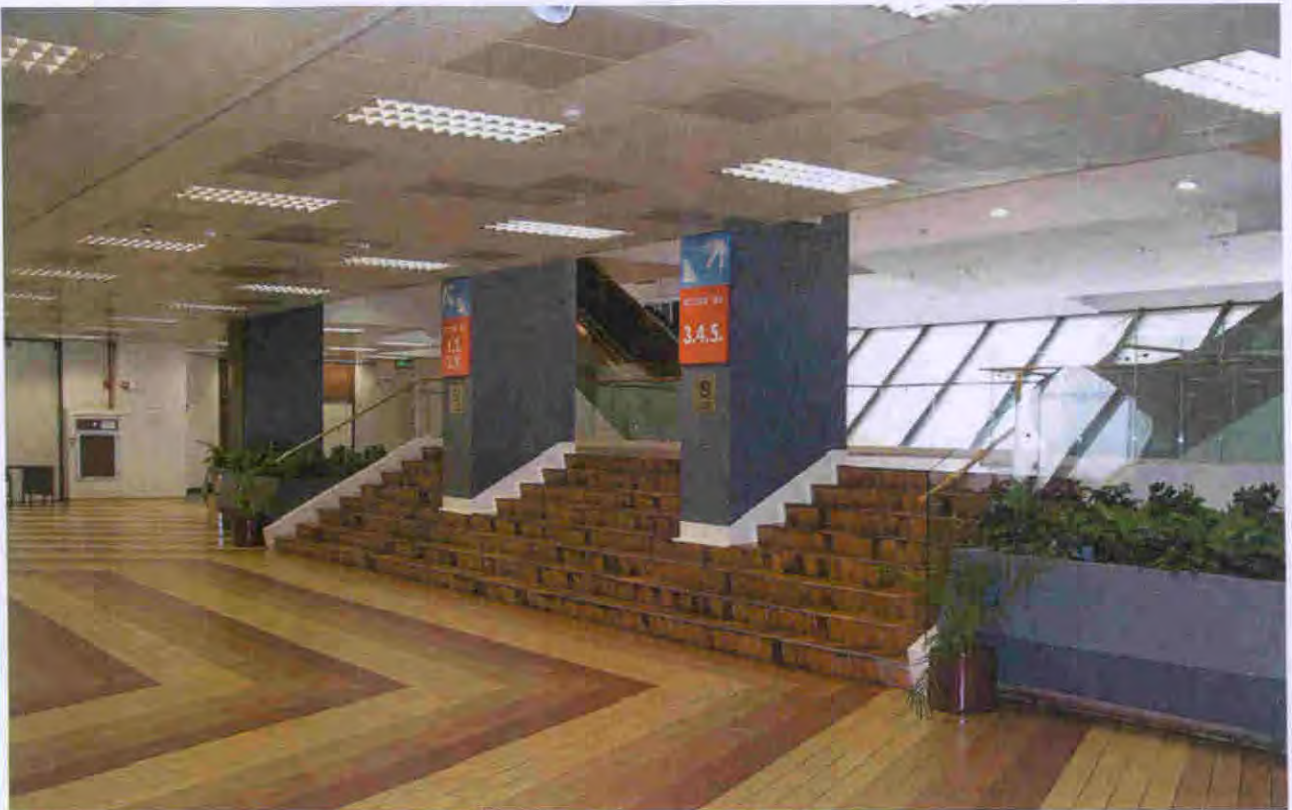
Improvement to Queen Elizabeth Stadium (Before) 伊利沙伯體育館改善工程 (工程前)
