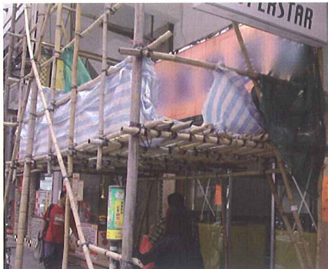
商舖鋪面工程
