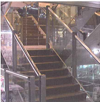
加建室內樓梯
