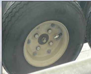
纜車站的輪軌現已全部更換
