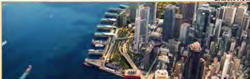
碼頭堤岸走廊
